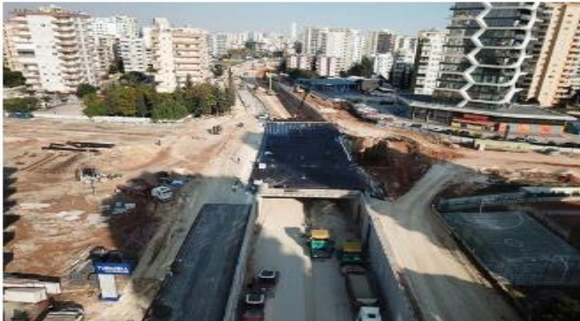
*Yenişehir ilçesinde Hüseyin Okan Merzeci Bulvarı ile 20. Cadde kesişiminde çalışmalarını başlattığı Katlı Kavşak Projesinde son aşamaya gelindi. Bordür ve kaldırımların çalışmalarına tüm hızıyla devam eden ekipler, sıcak asfalt dökümüne de başladı. Proje kapsamında toplam 20 bin ton sıcak asfalt dökülmesi planlanıyor.*
